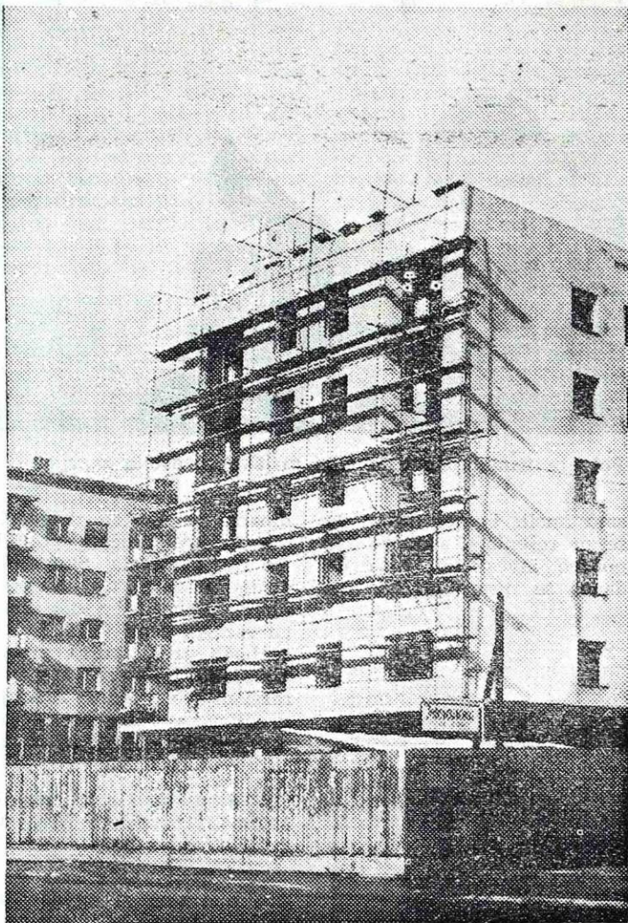
Poslovno-stanovanjska stavba v izgradnji
