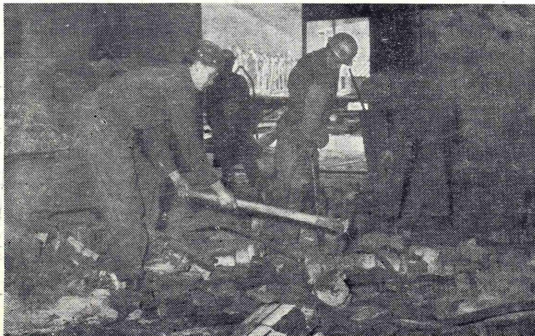
Rušenje dela obdelovalnice blokov
