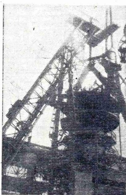
Vsip vozijo na žrelo plavža s posebnim dvigalom
