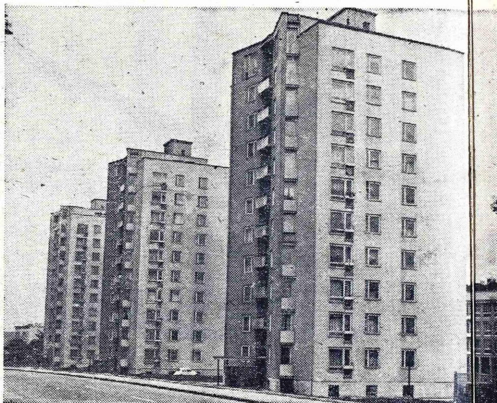
Na Tavčarjevi cesti so že začeli z nadzidavo stanovanjskega bloka, ne vemo pa, kdaj začeli s popravilom streh na stolpnih, čeprav so sredstva na razpolago. Ali bodo počakali zimo?
