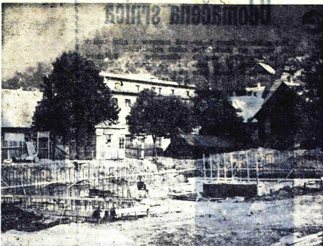
Ob kolesarski poti, med Prešernovo cesto in Cesto maršala Tita, pripravljajo temelje za novo samopostrežno trgovino podjetja PREHRANA iz Ljubljane
