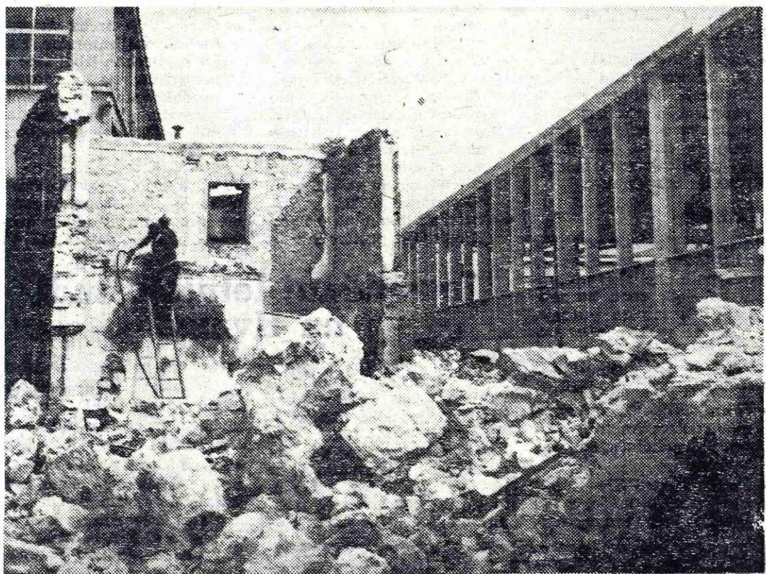
Ostanki stanovanjske hiše v Hrenovici po miniranju
