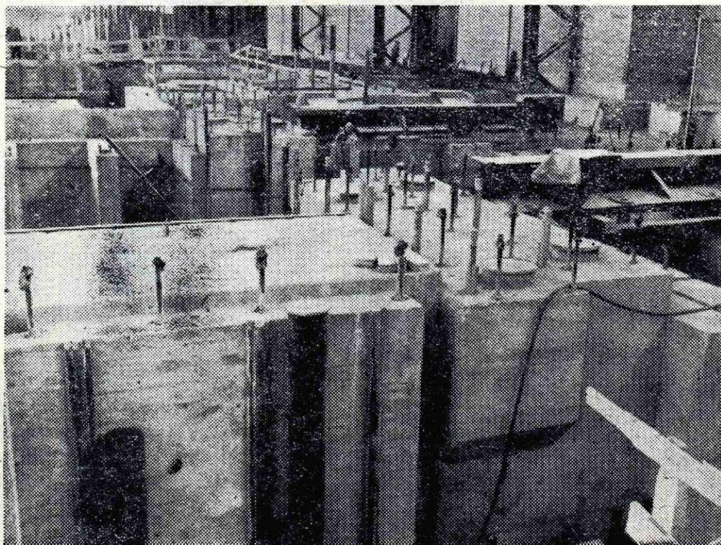
Izgradnja temeljev v novih valjarnah na Belškem polju
