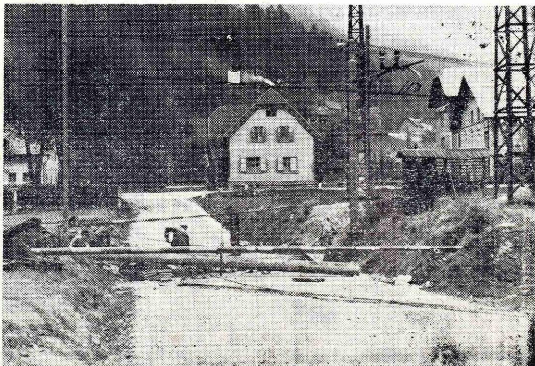
Zaradi elektrifikacije železniške proge in izgradnje novega nadvoza pri osnovni šoli na Koroški Beli so na treh dosedanjih prehodih odstranili zapornice, promet pa preusmerili čez novi most
