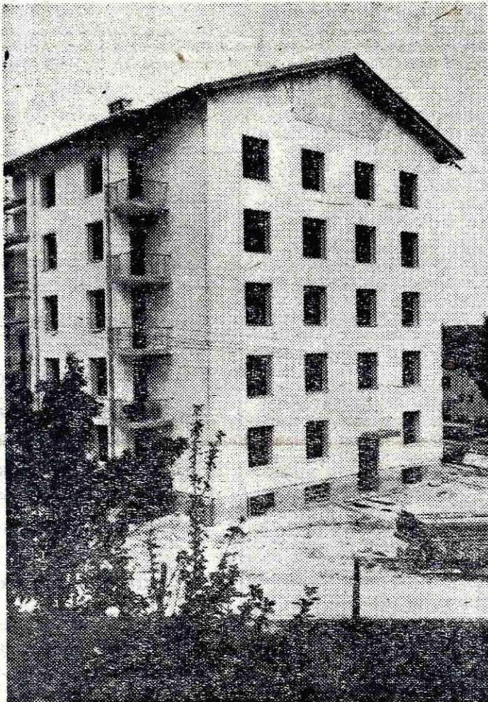
Manjka le še okensko steklo in lončene peči, pa bodo stanovanja v prvem stolpiču na Koroški Beli pripravljena za vselitev
