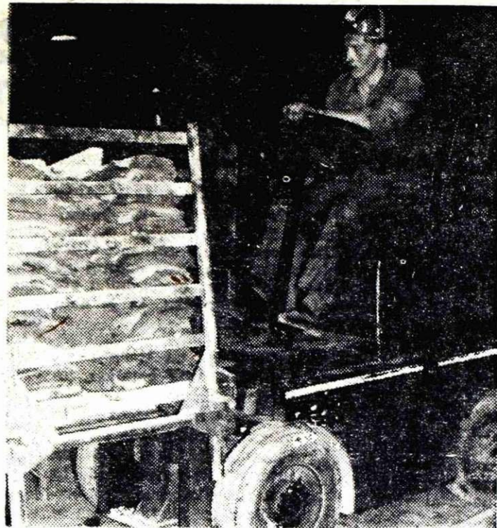
V šamotarni so dobili nov viličar, ki so ga izdelali podjetju INDOS. Njegova zmogljivost znaša 1,5 tone
