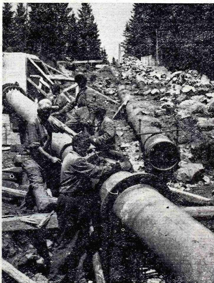
Nov cevovod za tlačno vodo za potrebe javniških valjarn že služi namenu
