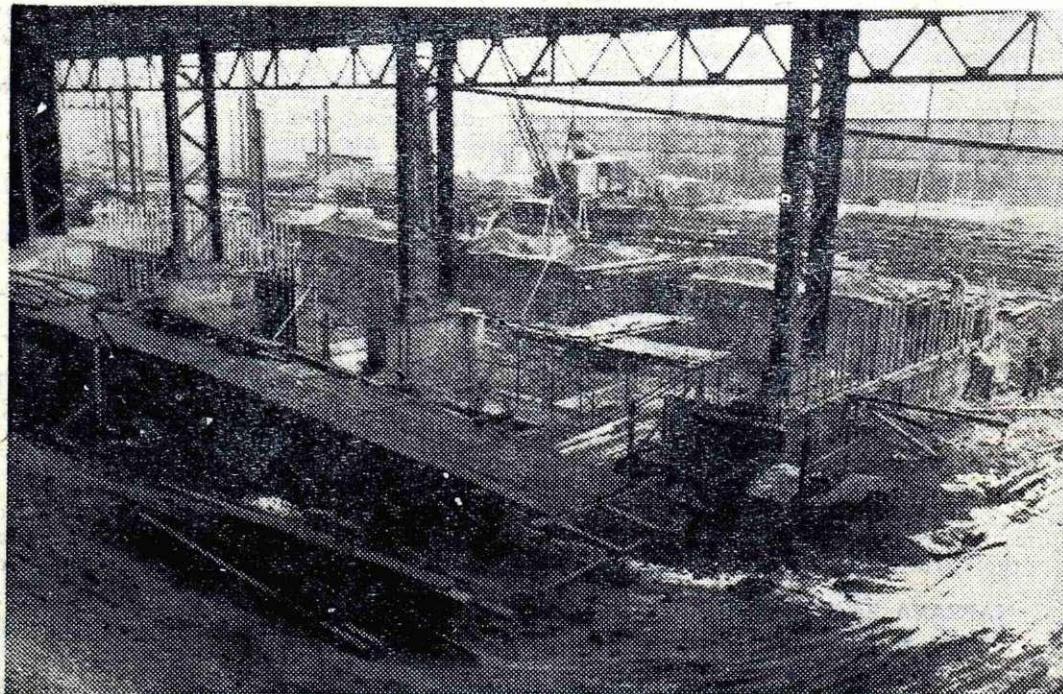
Trenutno na Belškem polju najbolj pospešujejo dela na izgradnji temeljev za opremo Delno zaradi hude in dolge zime, delno pa zaradi pomanjkanja delavcev gradbena podjetja kasnijo pri izgradnji hal
