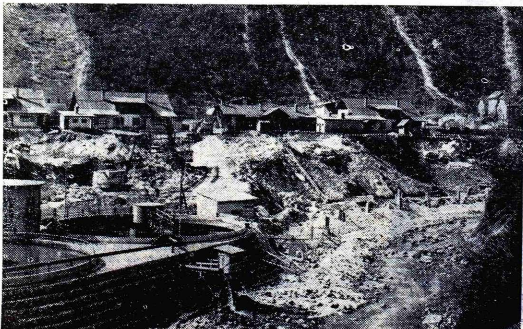
Ob Dorrovih čistilcih so začeli z izkopom temeljev za novo kisikarno.
