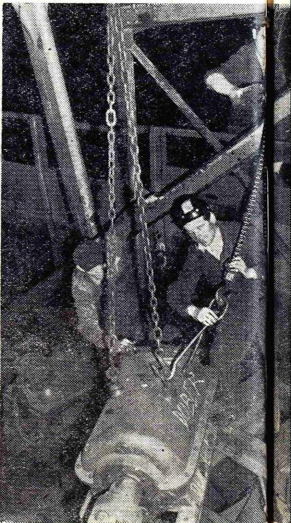
Menjava elektromotorja na Demag dvizni progi.
