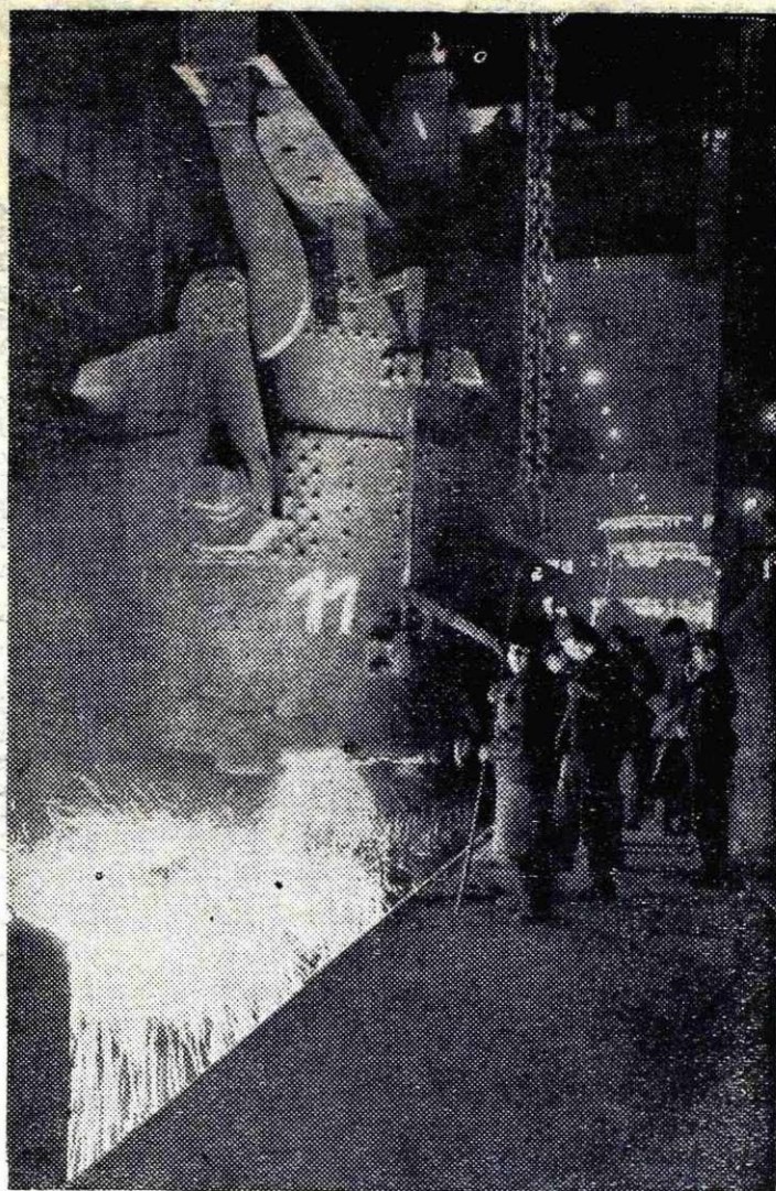
Iz livne jame v martinarni: vlivanje jekla v kokile
