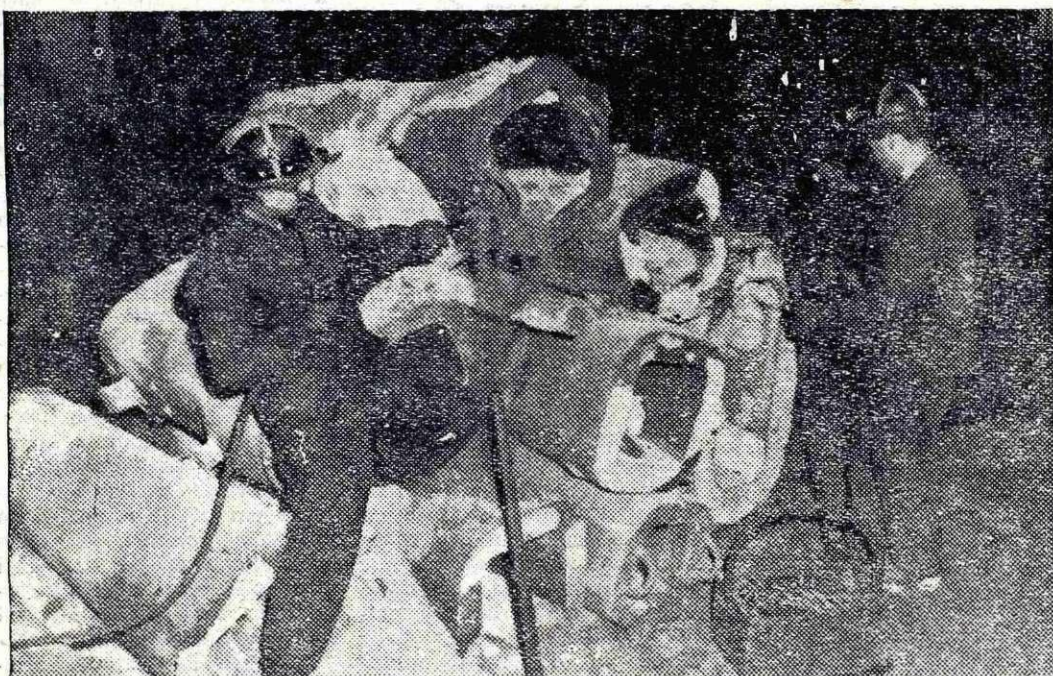
Tudi to delo morajo opraviti čistilci sive litine. Na sliki jih vidimo pri grobem čiščenju kokil.
