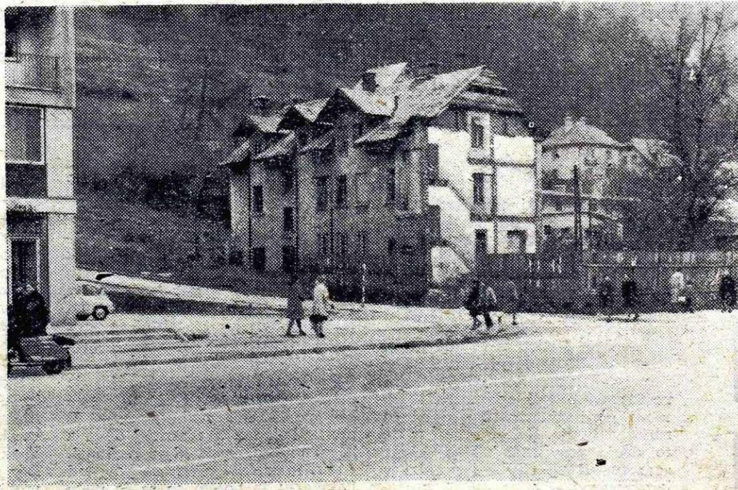
Peklarjevo hišo so začeli rušiti. Upajmo da bodo kmalu začeli na njenem mestu graditi predvideno poslovno zgradbo
