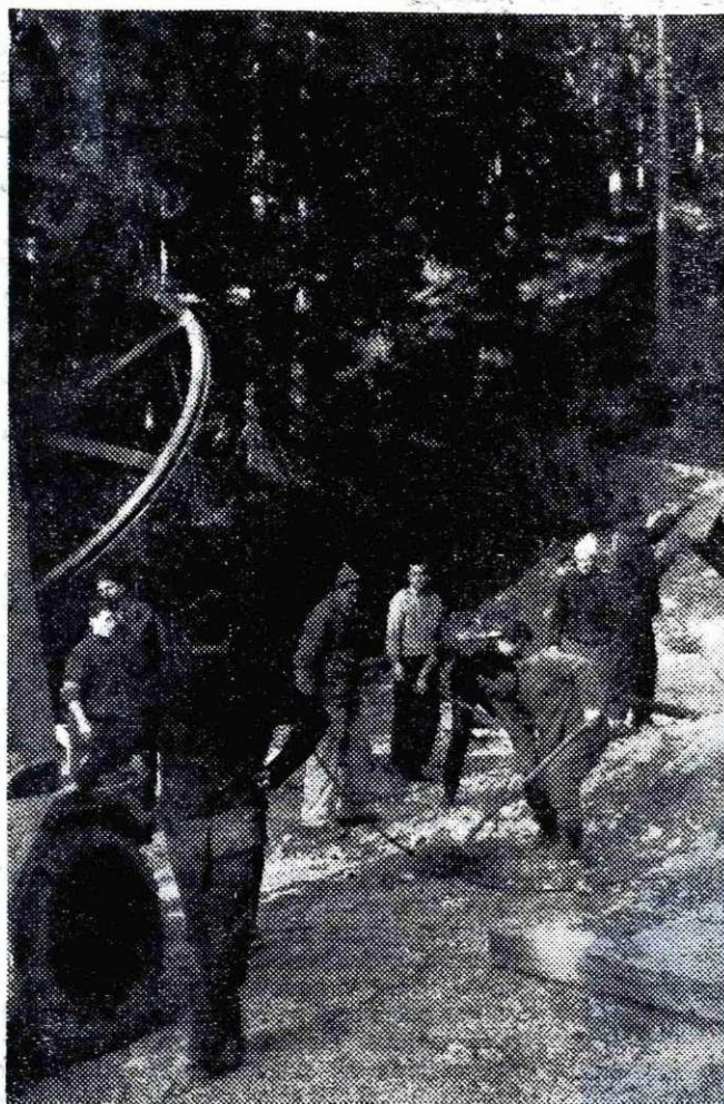
Montaža žičnice na Kresu
