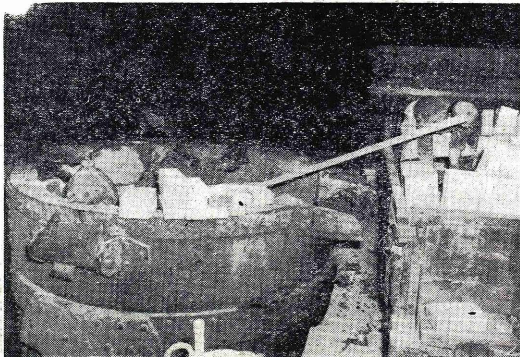
Ker so začeli s pripravami za postavitve nove električne peči, so morali premestiti ponovčarsko gospodarstvo
