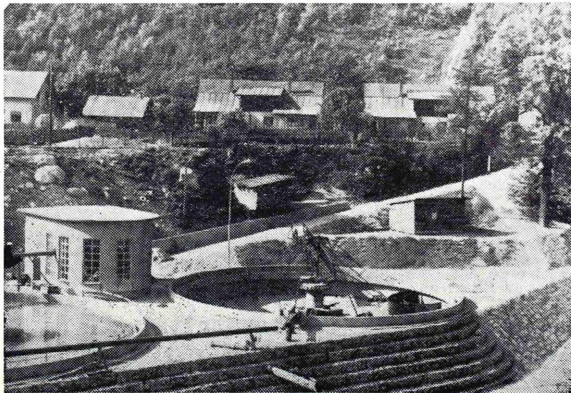
V neposredni bližini jeklarne na desnem bregu bo zgrajena nova kisikarna.
