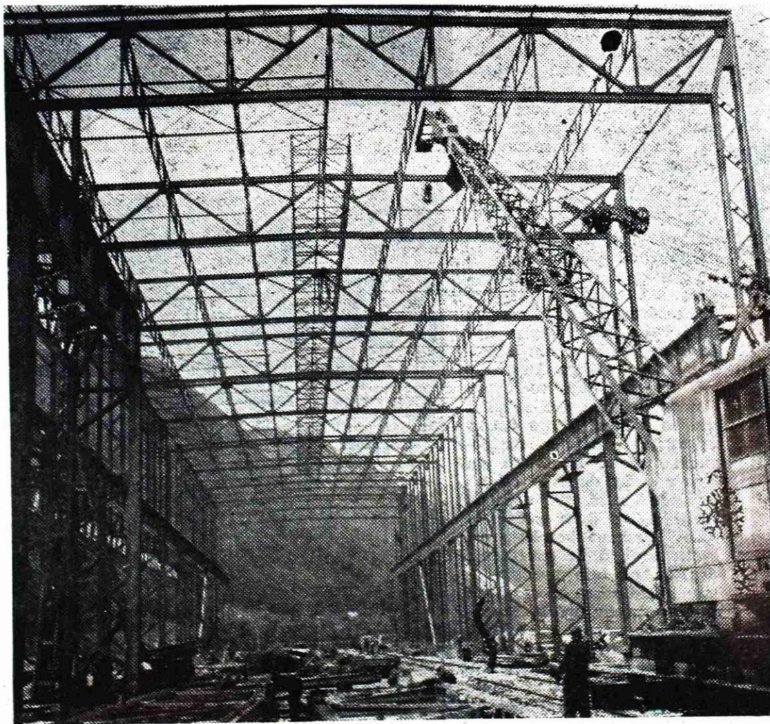
Dela pri izgradnji stripier hale zelo hitro napredujejo, tako da bodo hale izgotovili okrog 15 dni pred določenim rokom
