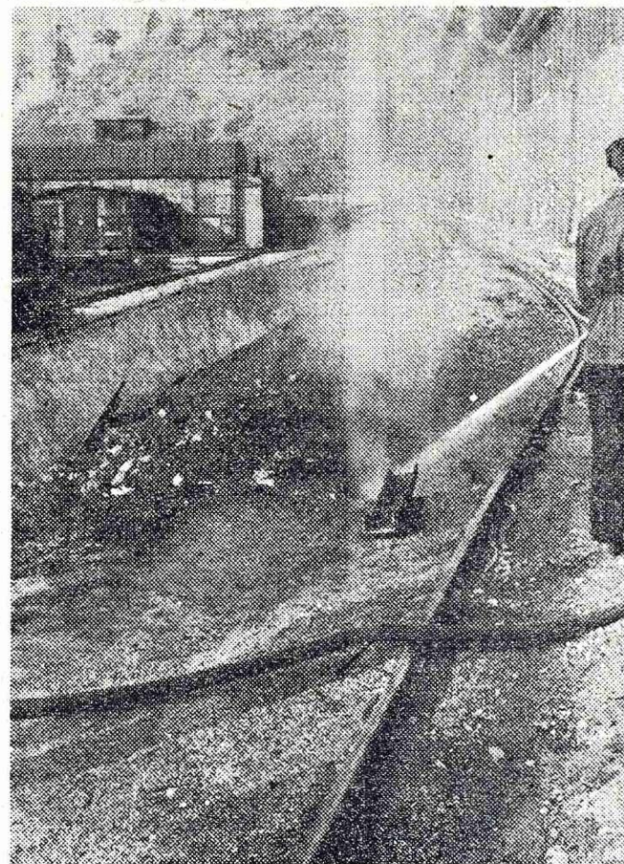
Požar VT kisikovega voda na Javorniku z dne 23. septembra 1961. Bakrena cev je gorela globoko pod zemljo.
