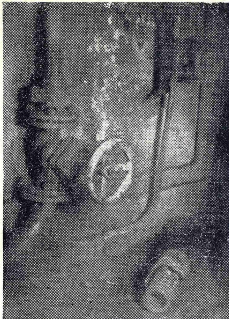
Vžig glavnega reducirnega ventila za valjarno 2400 v kisikarni na Javorniku z dne 5. 11. 1958. Od reducirnega ventila je ostala samo vzmet
