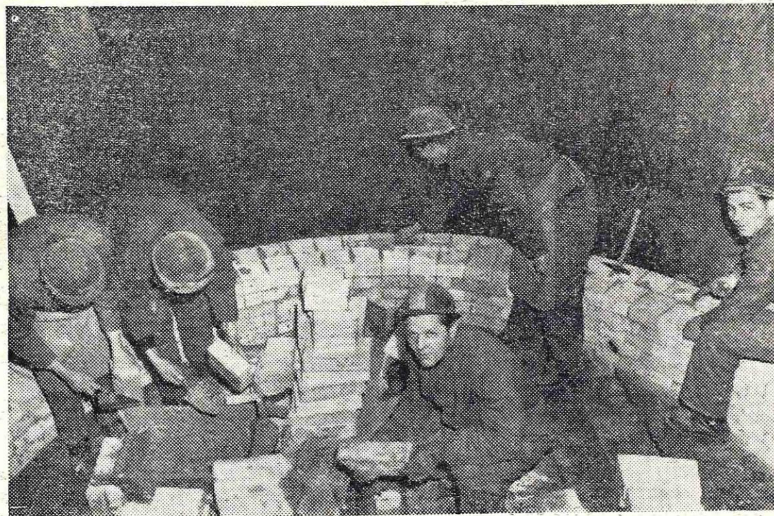
Obzidava sredine peči. Pri tem so prvič v naši državi uporabili nov način obzidave, ki ga vidimo na sliki
