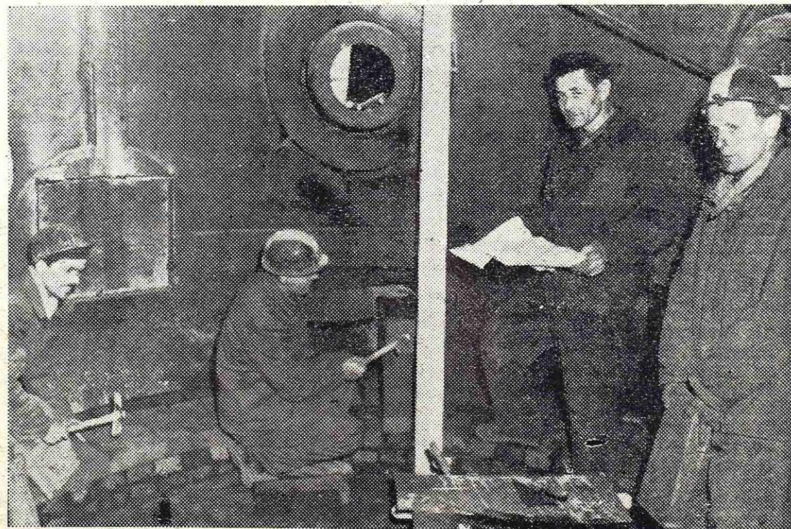
Med remontom so obzidali tudi talilnik na VP 2
