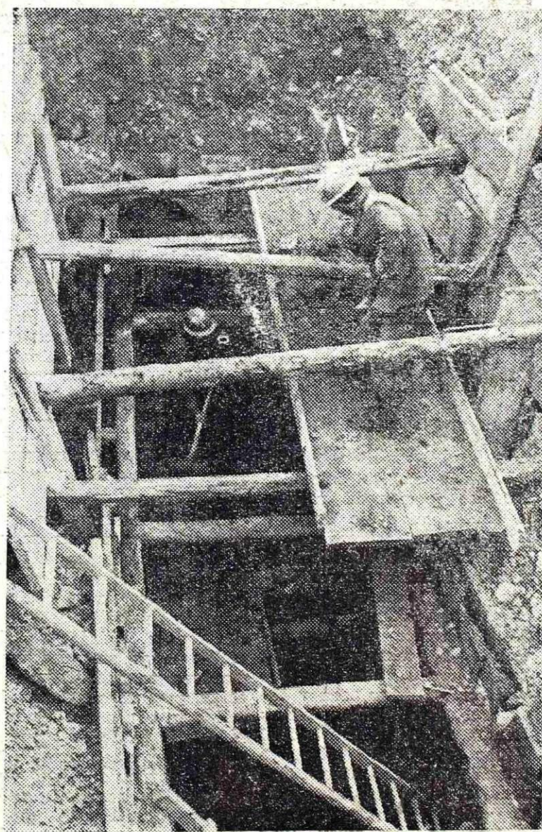
Najgloblje so morali na Belškem polju skopati na mestu, kjer bodo zabetonirani temelji za nosilce stripper hale, ki bo tudi najvišji objekt na novem delovnem prostoru naše železarne. Sneg je »odlezel« zato je živ-žav na gradbišču vsak dan večji
