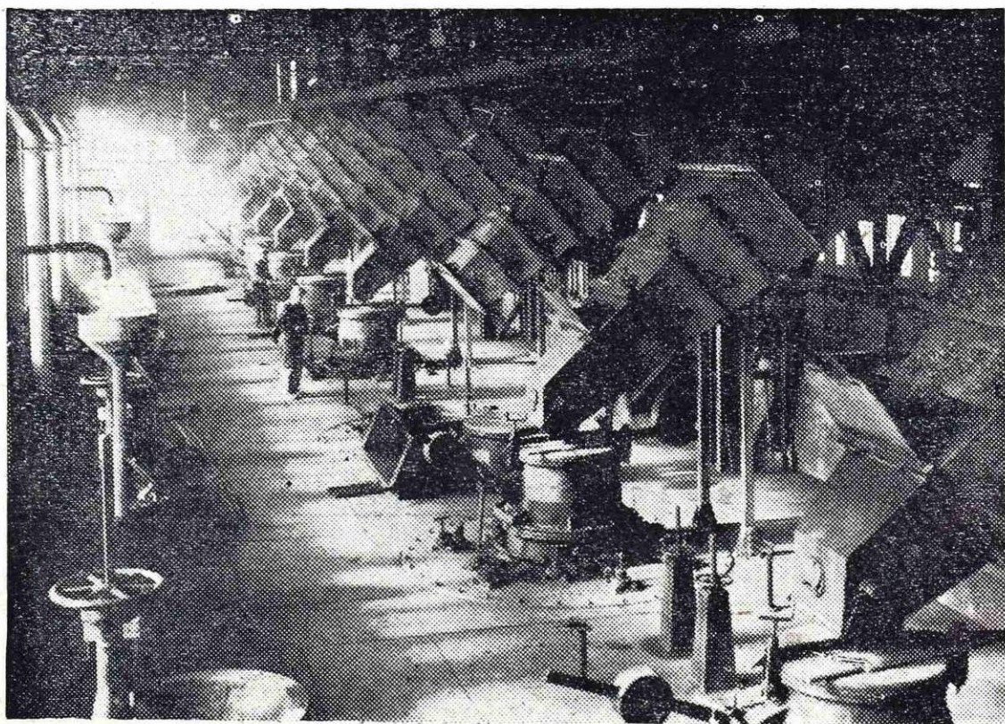
Generatorji na Javorniku oskrbujejo valjarne s plinom. Delo je naporno in včasih tudi nevarno.
