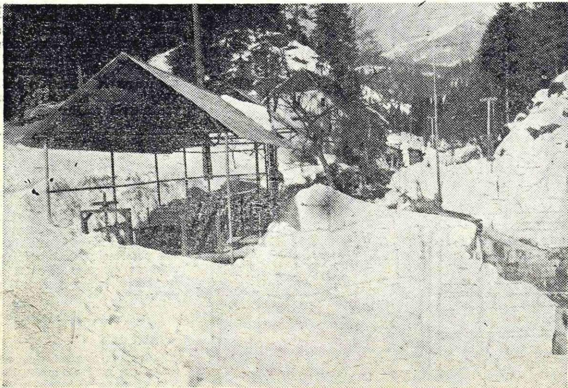
Zajetje hladilne vode v Trebežu. Hladilna voda je namenjena za potrebe naših valjarn.
