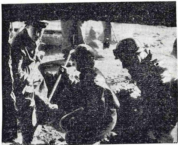
Med remontom na VP 2 so morali izrezati veliko odprtino v plašču, da so lahko odstranili veliko »svinjo«, ki se je nabrala od dna peči do vetrnih šob
