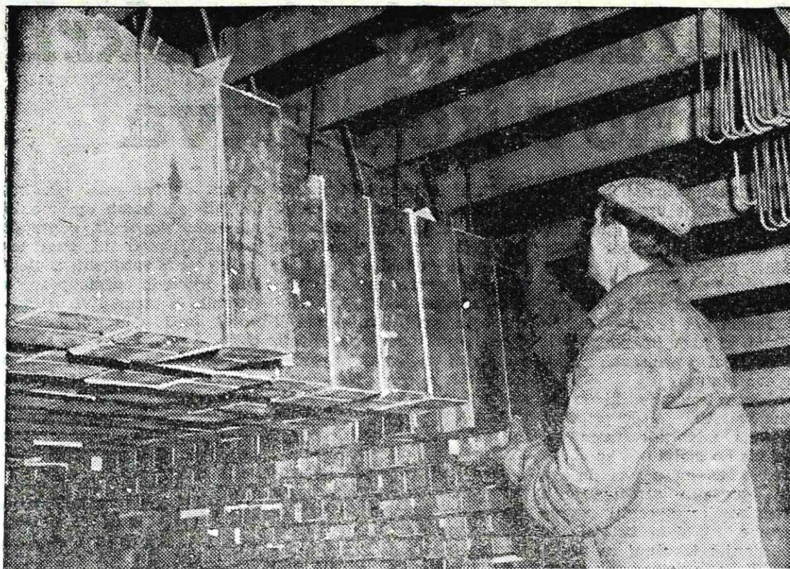
Na SM peči V so prvič v Jugoslaviji izdelali obok po novem sistemu tako, da se ne nosi sam
