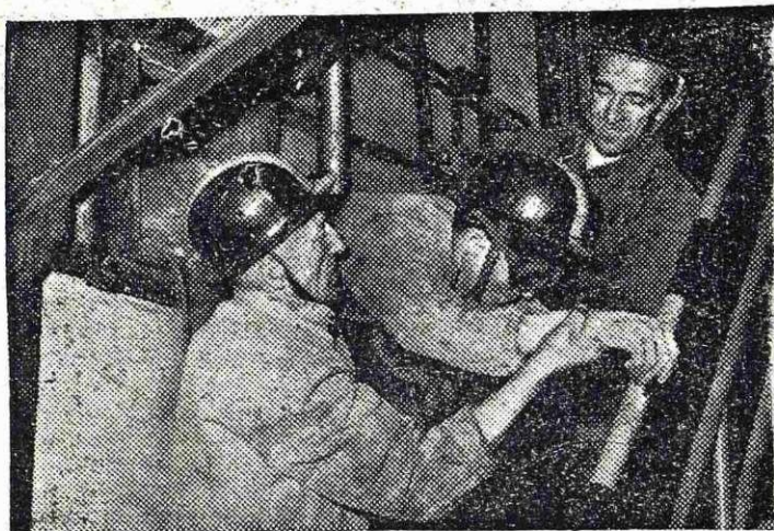
Delo pri čiščenju saj in nasledkov v vročem kotlu je naporno, zelo težaven pa je tudi dostop
