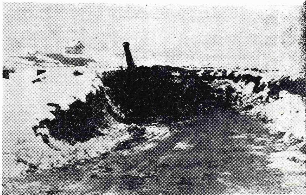
Takole pripravljajo teren, kjer bo stala strojnica na Belškem polju
