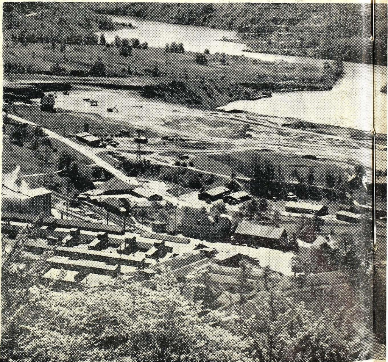
Marsikdo je zmajeval z glavo, ko so začeli z zemeljskimi deli na Belškem polju
