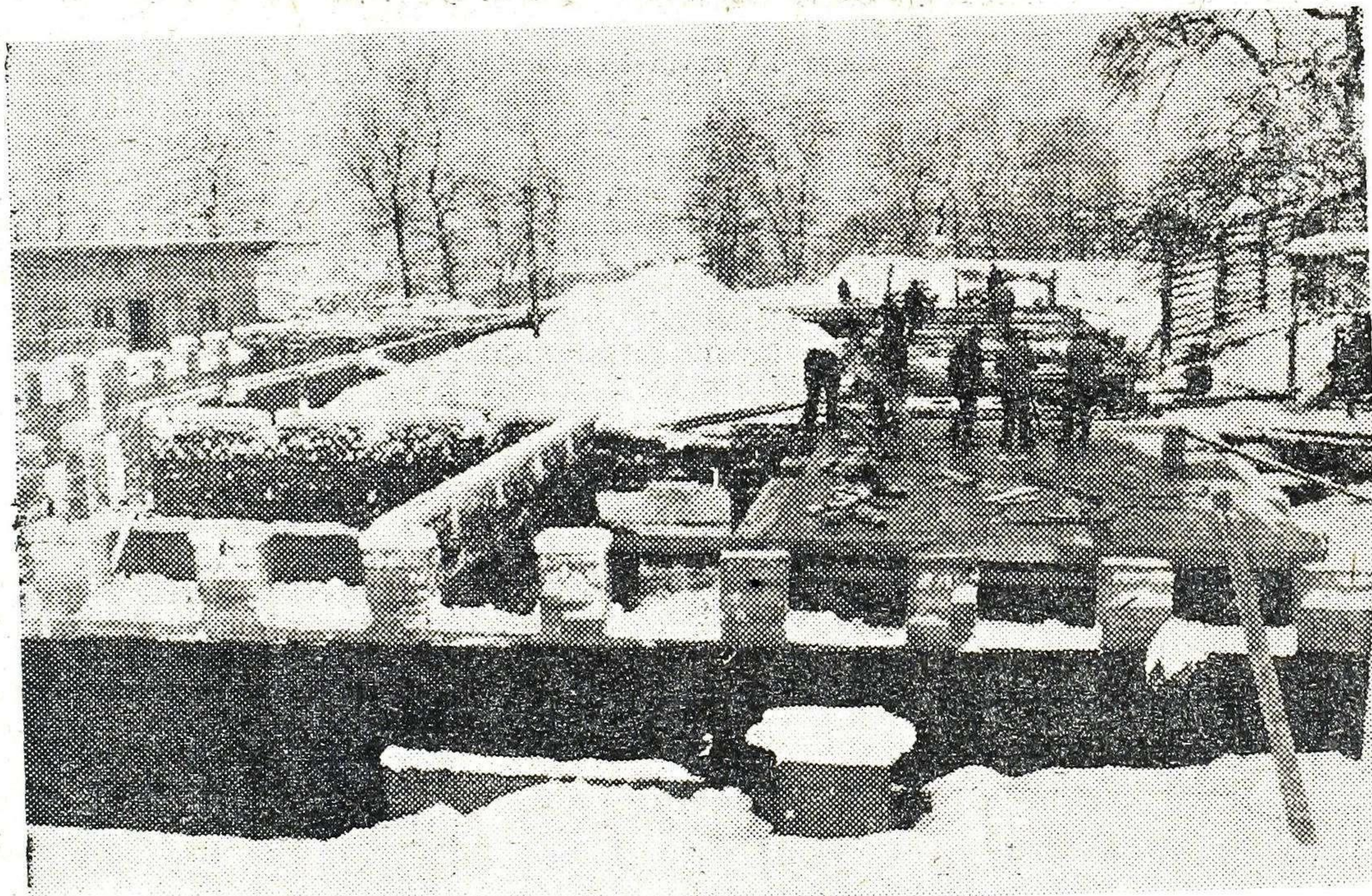
Na Javorniku so začeli z gradnjo kulturnega doma. Če bodo vremenske prilike ugodne, bodo lahko še letos zabetonirali betonsko ploščo
