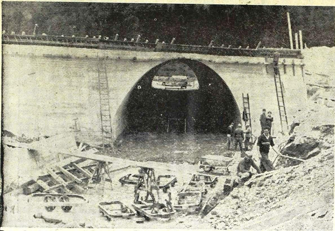
Betonska dela pri prepustu za potok Javornik so zaključena
