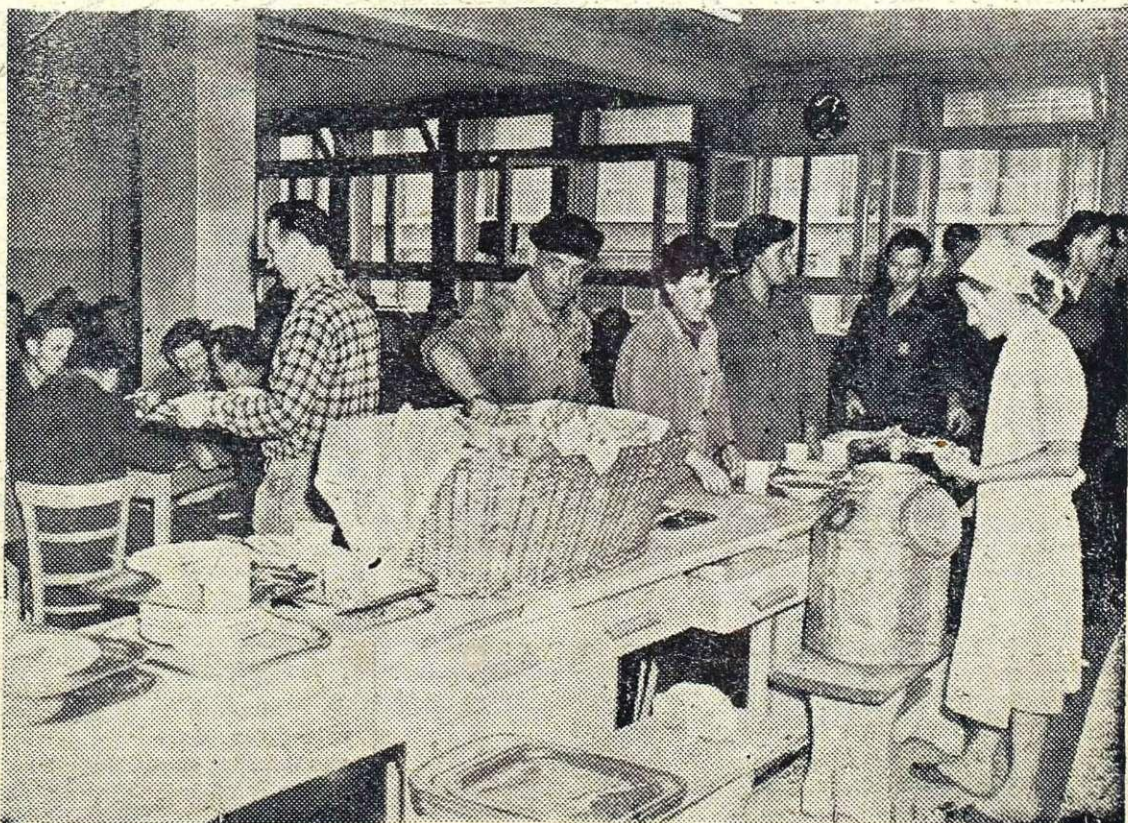
Malica se je začela. Dober tek! (Na sliki delilnica v predelovalnih obratih).
