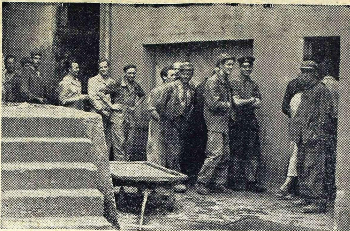
Prizor, ki ga vidite na sliki, je še vedno precej pogost, posebno pred delilnico v martinarni.
