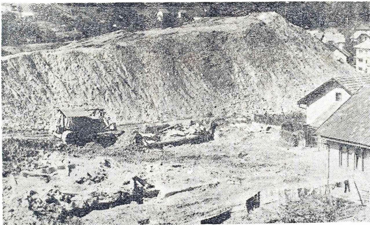
Dveh montažnih hiš ni več. Odstraniti so jih morali, da so lahko nadaljevali z deli pri gradnji nasipa
