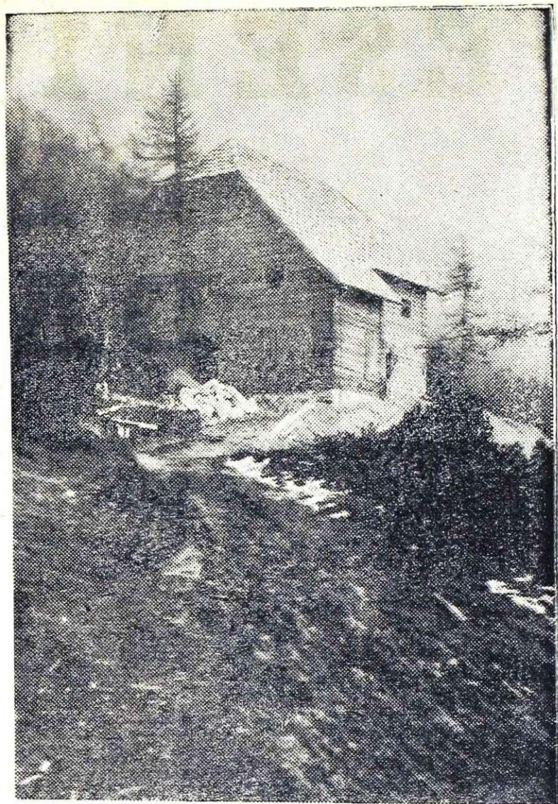
Tičarjev dom na Vršiču med gradnjo. Pobudo zanj je dal dr. Josip Tičar in se zato tudi po njem imenuje
