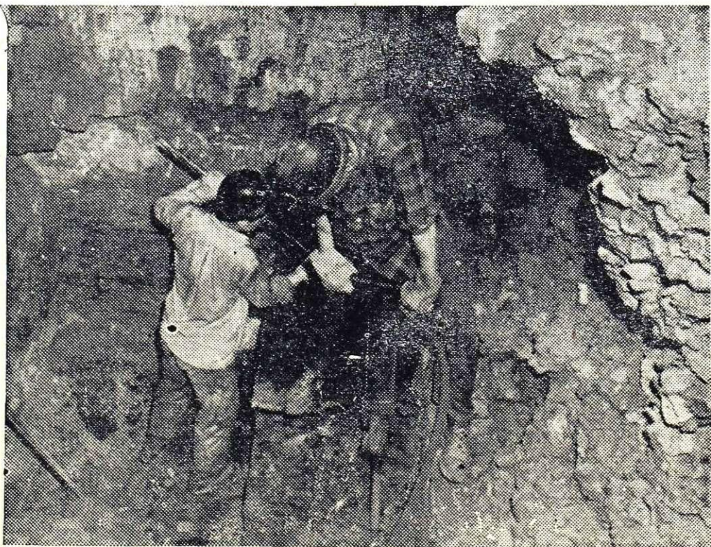
Industrijska zidarja pri delu med remontom v martinarni
