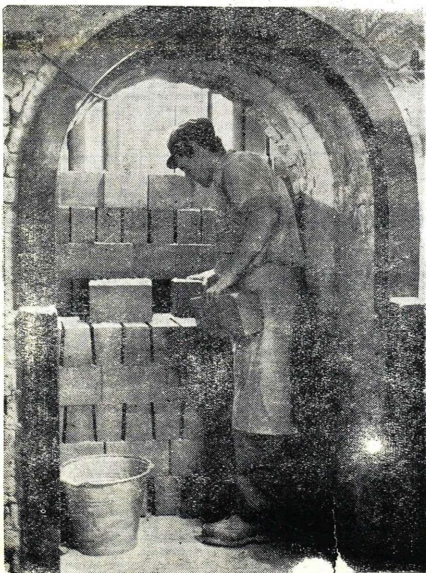
Delavec v šamotarni pri zlaganju opeke v peč. Opeka mora biti pravilno zložena, tako da plamen zajame vso opeko in da je lepo in ekonomsko žgana
