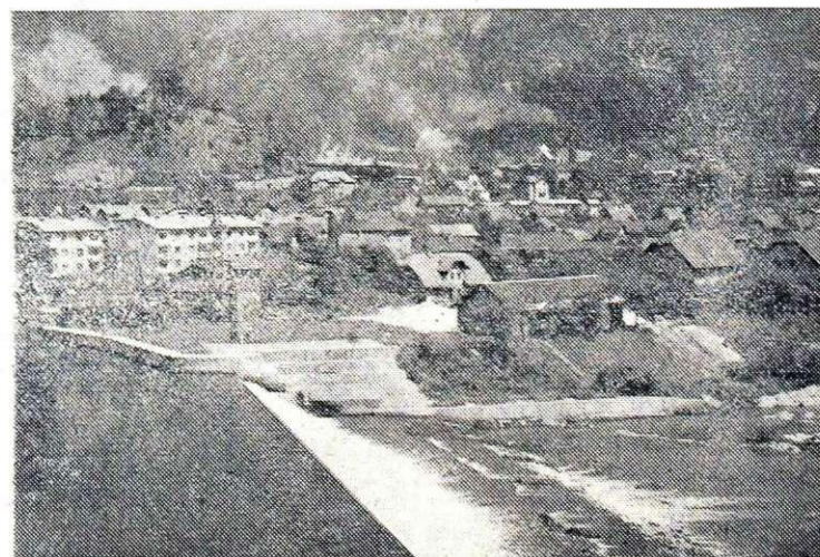
V bližini peskolovca HC Moste so pred kratkim začeli z gradnjo novega mostu čez Savo
