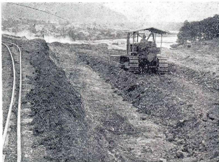
Prva dela na nasipu so se že začela
