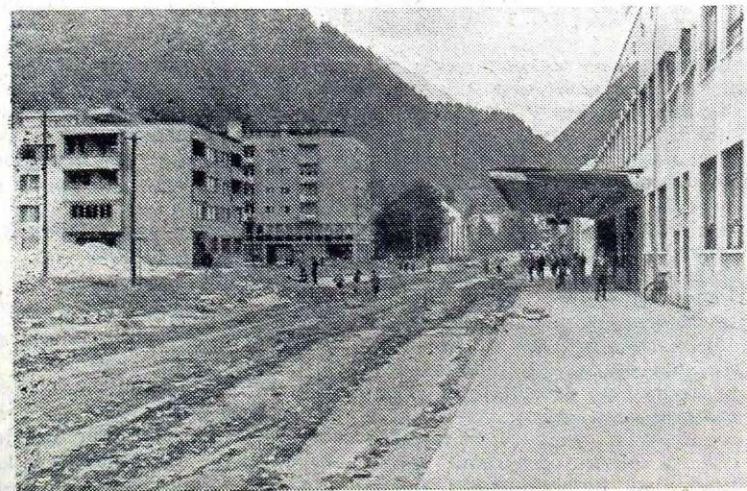
Razorano cestišče pred železniško postajo terja pospešeno gradnjo
