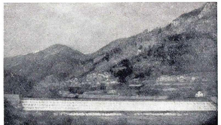
V neposredni bližini peskolovca na Javorniku bodo začeli z gradnjo novega mostu
