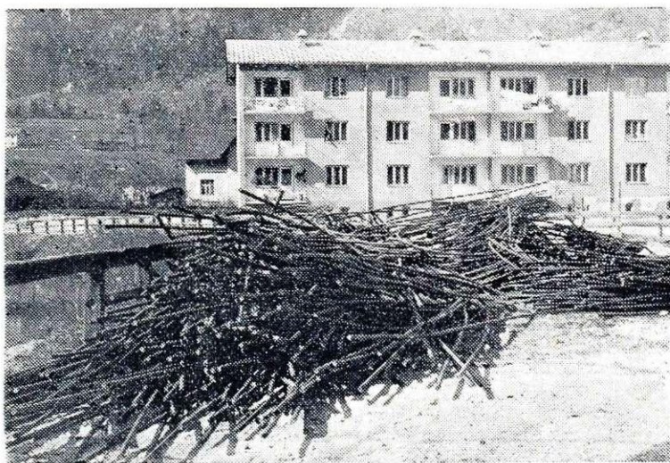
Betonsko železo je že pripravljeno za nov most čez Savo
