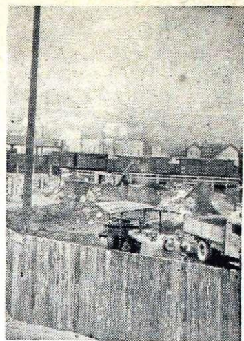
Z vsjo moderno tehniko je otvorilo gradbeno podjetje »Gradis« novo gradbišče na Jesenicah
