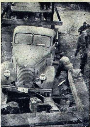
Reševanje kamiona, pod katerim se je porušila preperela mostna konstrukcija
