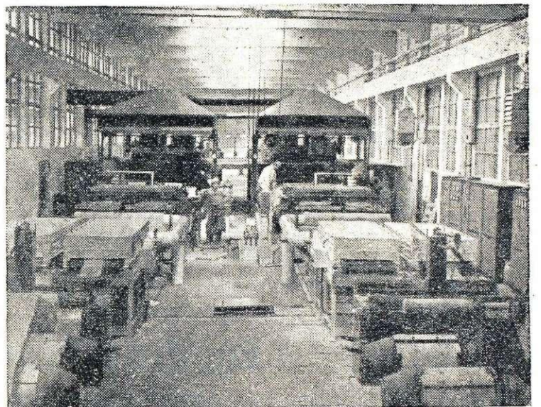
Pogled na progi za kositrnanje trakov v predelovalnih obratih
