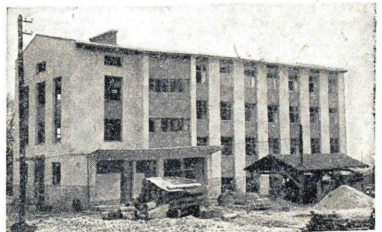
Novi upravno-higienski prostori za valjavniške obrate na Javorniku tik pred dograditvijo
