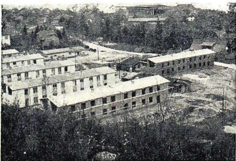
Osmerčkji pod Mežaklo v gradnji, medtem ko so se v tri že vselili hvaležni stanovalci
