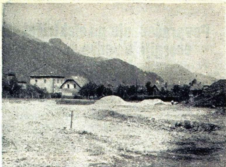
Po prvih grobih zemeljskih delih na novem gradbišču dvanaajstorčkov na Javorniku so se dela zopet ustavila
