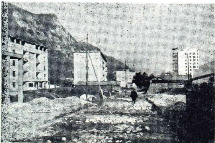
Plavžki frontovci in gradbeno podjetje »Nova Gorica« bodo s skupnim delom uredili naselje Plavž v moderno industrijsko središče. — Na sliki: začetek gradnje nove ceste,
