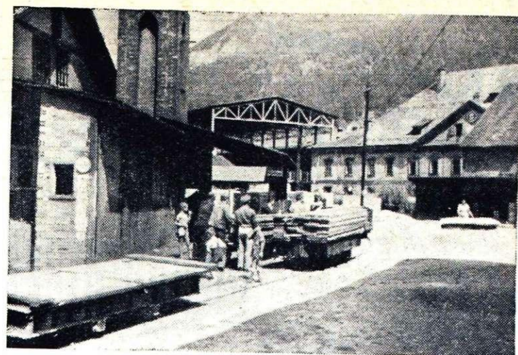
Opuščena opekarna, ki stoji na mestu, kjer so nekoč stale prvotne savske fužine, je ponovno zaživela. Nikjer pa ne manjka naših pionirjev, ki spremljajo delavce na vsakem koraku
