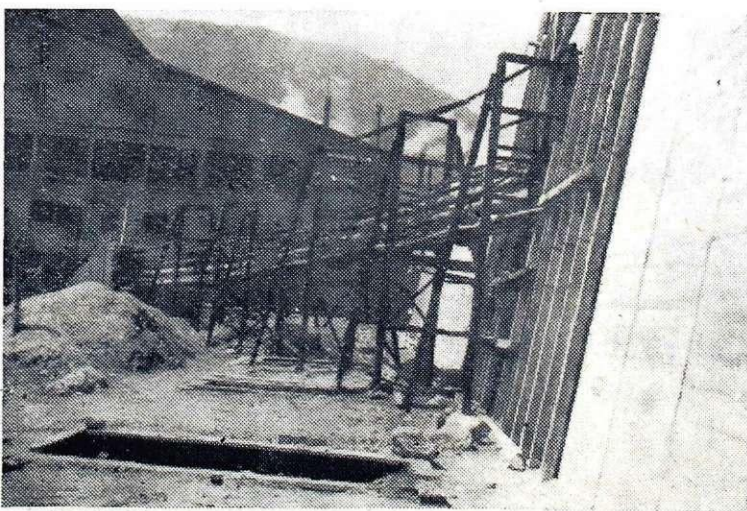
Vene javorniških valjarn, so postale ovira pri iskanju prostora. Toda problem bo kmalu rešen — svoje mesto bodo našle v betonskem jašku, ki je v zadnji fazi gradnje
