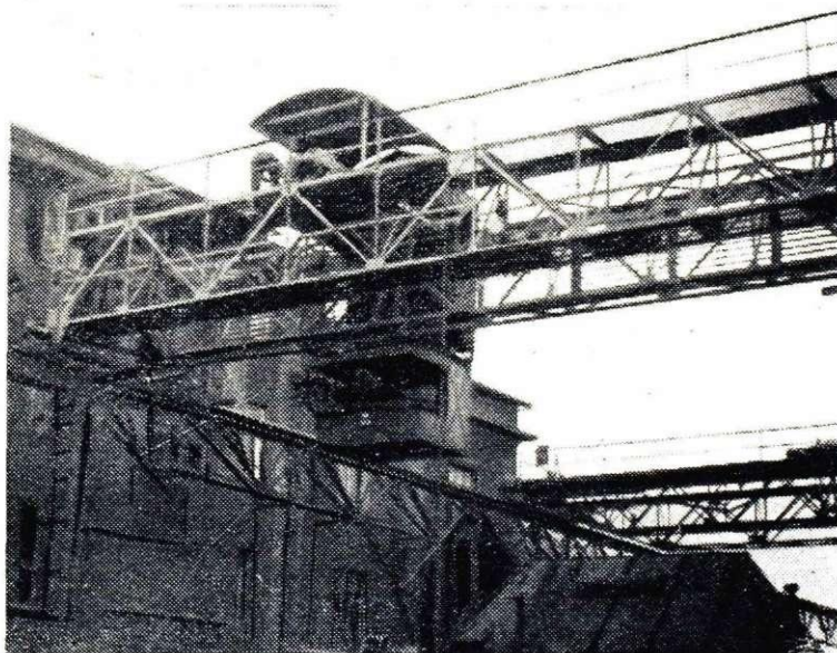
Zadnja dela pri montaži novega žerjava v starem železu
