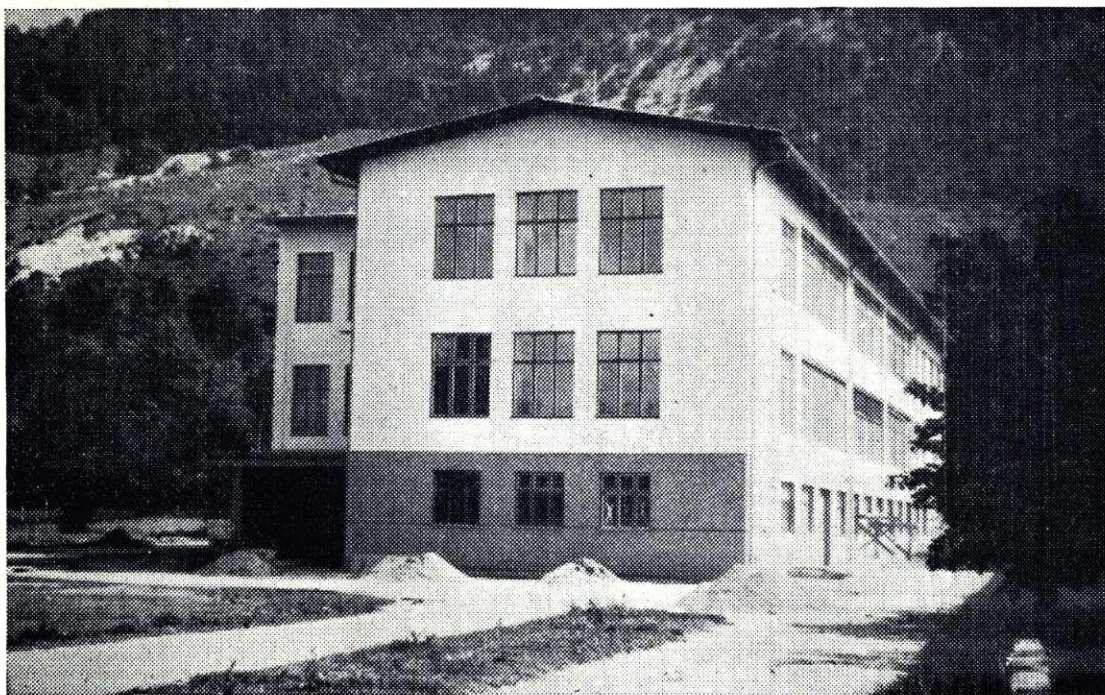
Novo šolsko poslopje v Žirovnici
