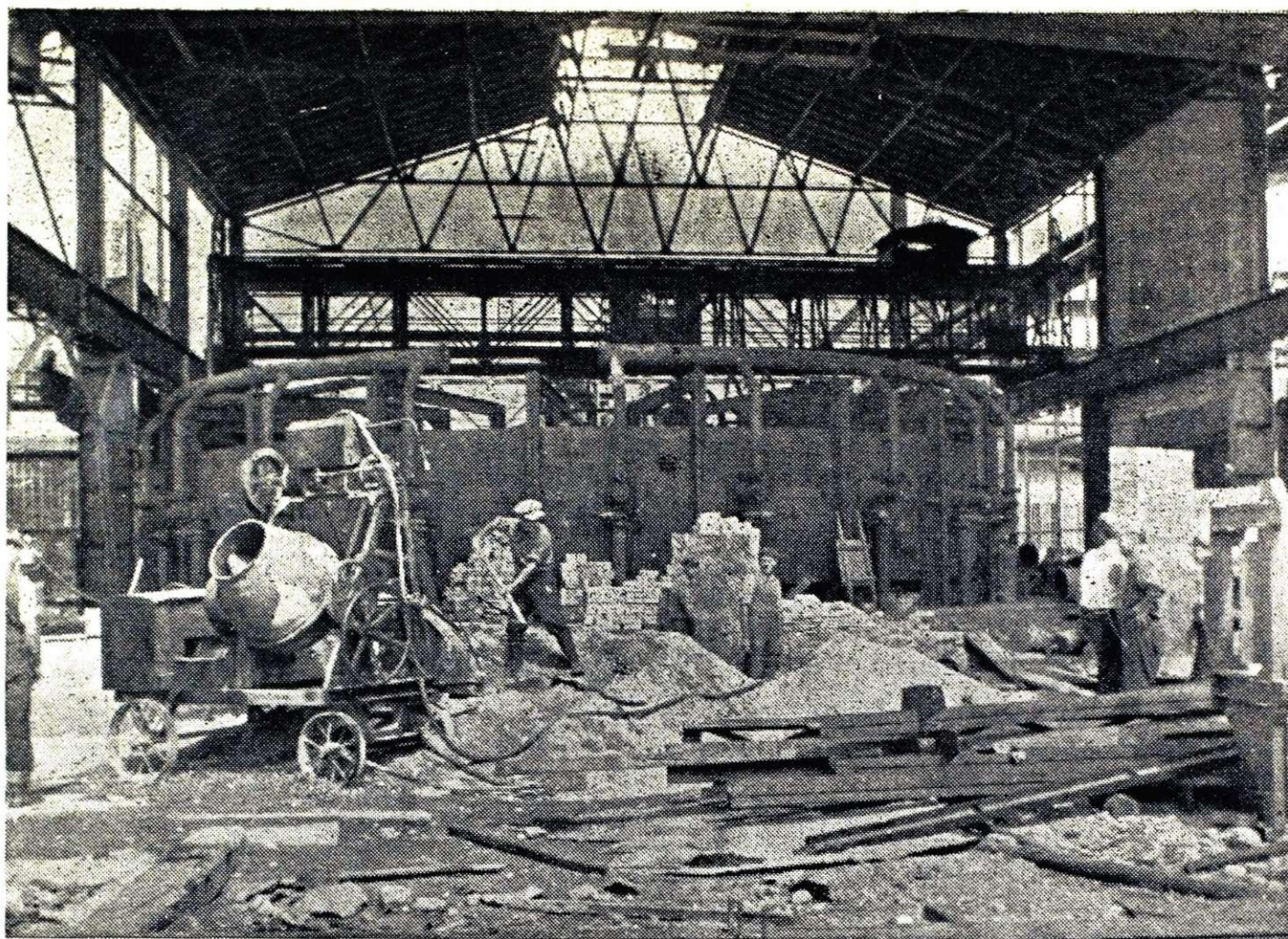
Slika 3 (k članku na str. 152). Gradnja okrogle peči ingotov
